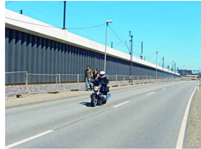
Historische Relikte gibt es nur wenige in der HafenCity, auch die alte Pfeilerbahn (rechts oben) wurde inzwischen abgebrochen und durch einen modernen Bahndamm ersetzt.
